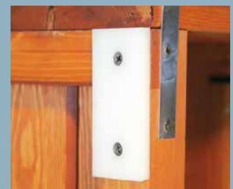
PE-Gleiter, Schwimmbadbereich, Rahmenschutz gegen Feuchtigkeit
