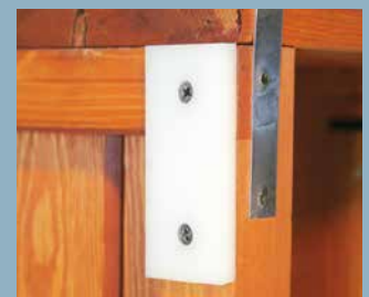
PE-Gleiter, Schwimmbadbereich, Rahmenschutz gegen Feuchtigkeit
